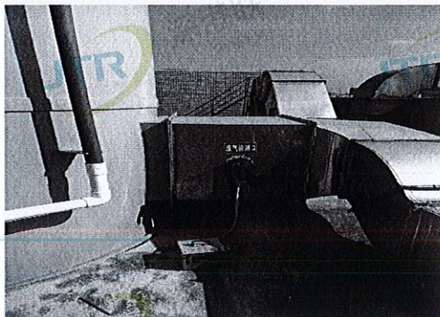
3#有机废气处理前监测口
